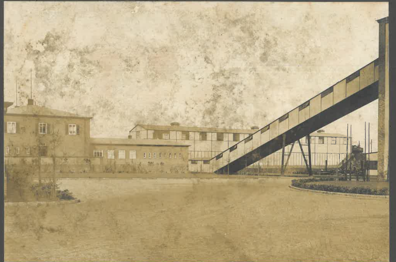
Fabrik Regis: Vortof Kaptine, Bunker mit Bandbrücke
